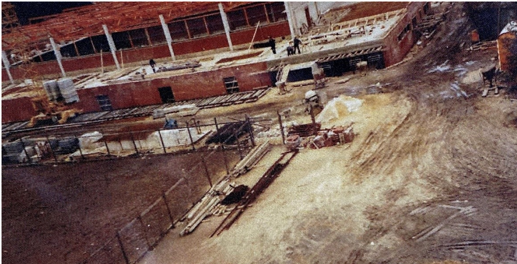
Bau der Sporthalle 1980 – Quelle: Realschule Hohenwedel. Eine Zeitreise 1976 - 2015
