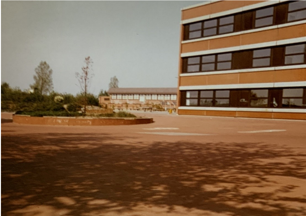
Fertiggestellter OS-Anbau 1979 - - Quelle: Schulchronik der Orientierungsstufe Hohenwedel
